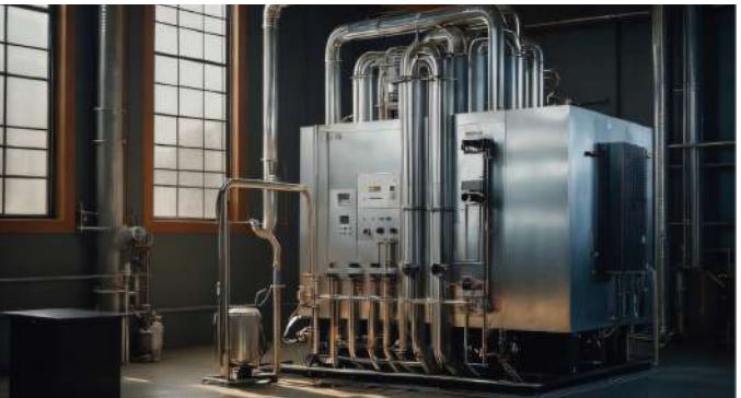
보일러 고온 배기가스로 수관의 물을 가열하여 사업장 곳곳에 공급
